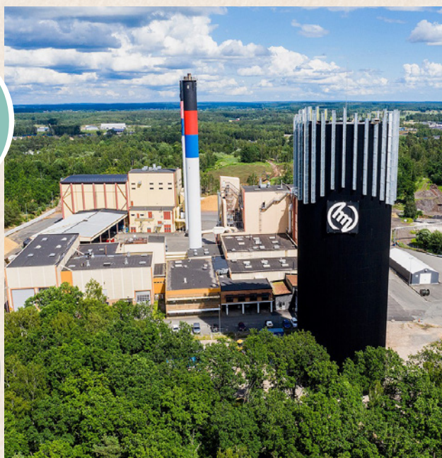
Värmeverket i Hässleholm 2020. Foto: Thomas Johnsson.
