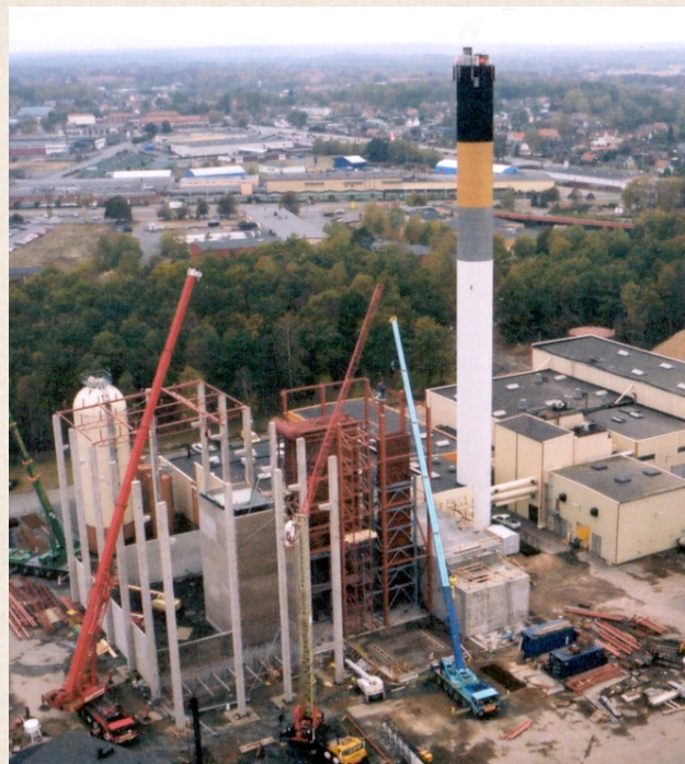
Bygget av avfallspannan på värmeverket under tidigt 2000-tal.
