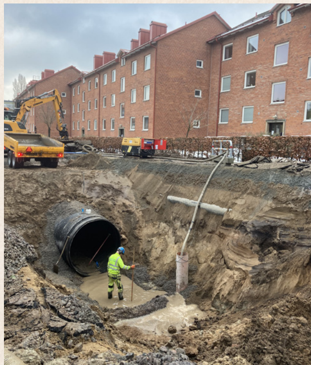
Ett 50 meter långt dagvattenmagasin installeras på Kaptensgatan.
